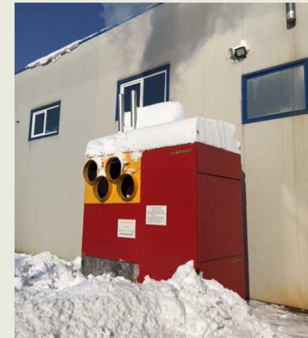
GHP - 600kw, Conditii climatice: minus 15 C - debit: 27.000 m 3 /h la 70 C
