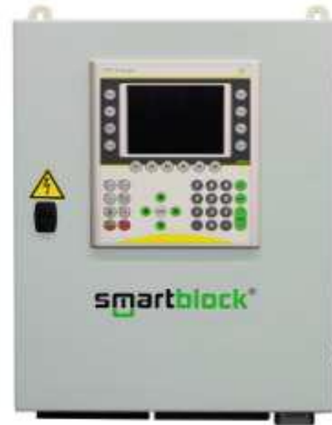
BR06 – panoul de automatizare
