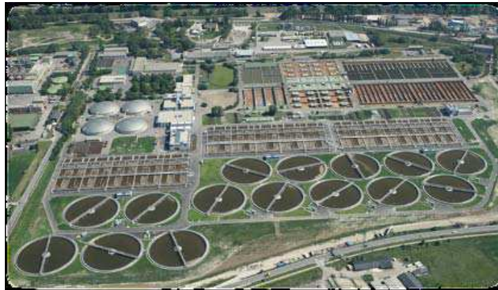
Statie de tratare a namolului
