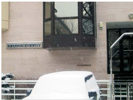
Clădirea "Kronos Energy" îi găzduiește și pe reprezentanții firmei "Galaxy Energy" în țara noastră.
