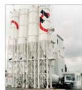
"Holcim" România a inaugurat la Chitila prima stație ecologică de betonare din Capitală
