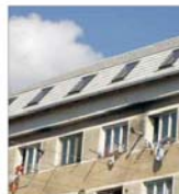
Mansardarea - soluție pentru reabilitarea blocurilor
