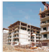
Proiecte pentru construcția a circa 8.000 de apartamente în Oradea
