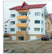
ANL începe construcția a 124 apartamente în Municipiul Arad
