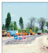
Au început lucrările la șoseaua de centură a Iașului
