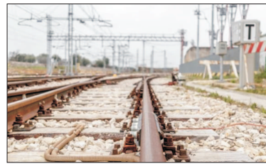
Cale ferată în dreptul unei stații de tracțiune electrică
